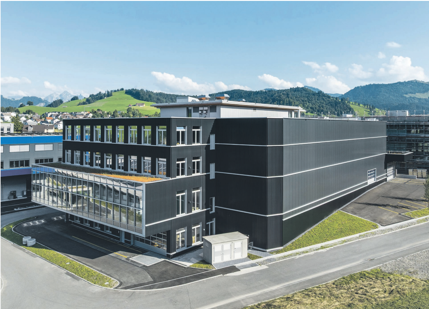
Markant und zugleich ruhig präsentiert sich die fensterlose Westfassade, hinter der sich das Hochregallager mit 126 Lagerplätzen und einem Lager- volumen von knapp 10'000 Kubikmetern verbirgt.
