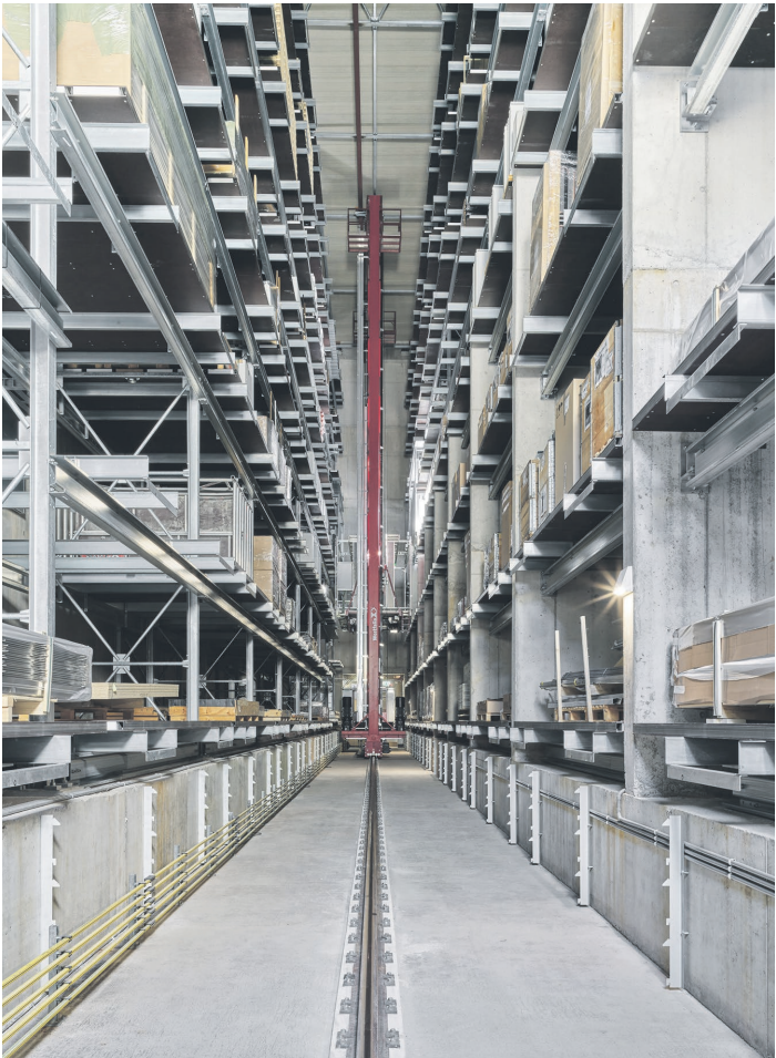
Das computergesteuerte Regalbediengerät verwaltet die eingelagerten Materialien und erlaubt die Ein- und Auslagerung auf allen 5 Geschossen. Dank der grossen Nutzlast und einer Stauhöhe von bis zu 1.9 Metern wäre sogar die Lagerung von Autos möglich.
